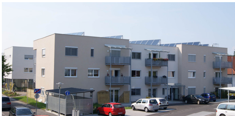
Wohnsiedlung Chance B mit Solaranlage
