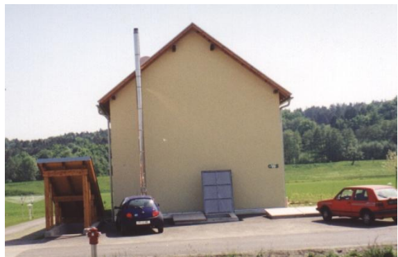
Abgang und Befülldeckel für den am Geschößwohnbau angebauten Heiz- und Lagerraum
