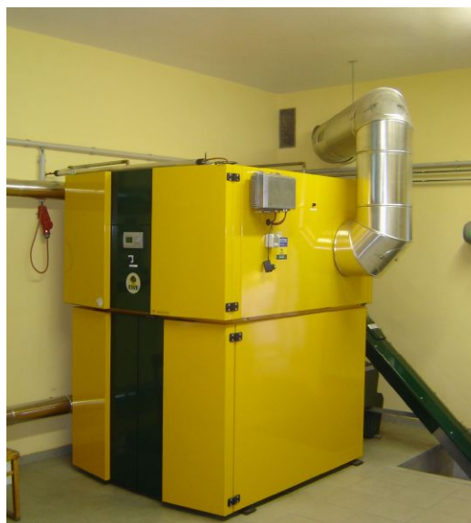
150 kW-Kesselanlage
