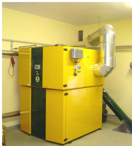
150 kW-Kesselanlage
